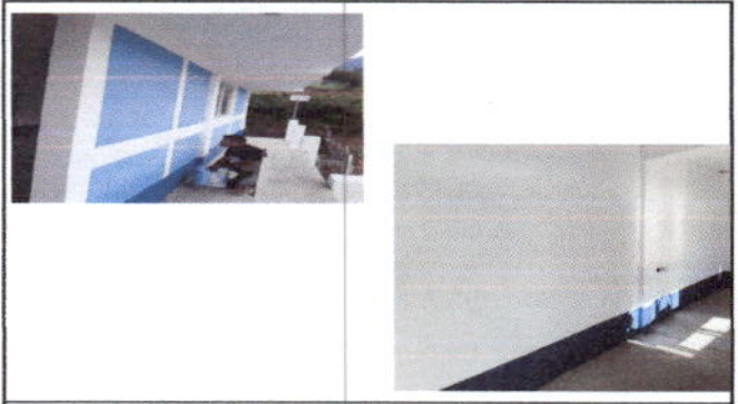
Foto 2: PINTADO INTERIOR Y DE EXTERIOR EN COCINA DE BLOCK
